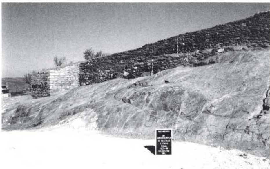
FIGURA 33. Área 2. Estado final tras las labores de adecuación y la reintegración volumétrica.
