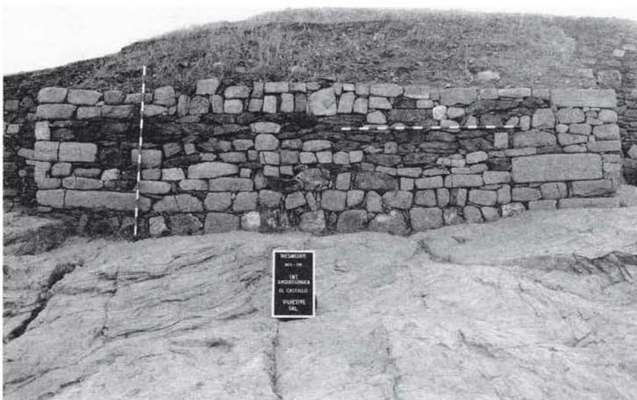
FIGURA 25. Frente de la torre de flanqueo central correspondiente al recinto medieval y reaprovechada en Época Moderna.
