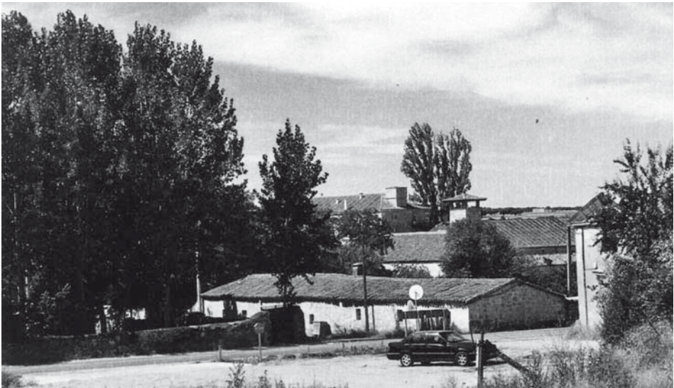
Instalaciones de la Granja Zorita, a la izquierda de la carretera y rehabilitadas recientemente como Hacienda Zorita
