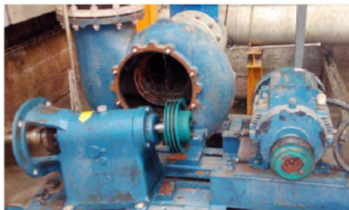
Detalle montaje bomba agitación digestor
