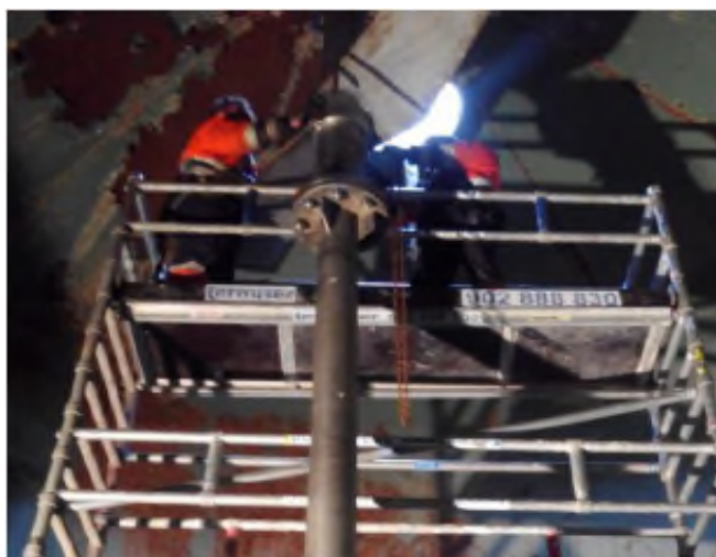
Detalle trabajos instalación agitador
