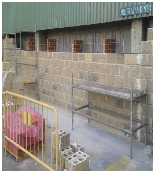
Reparación y refuerzo de pared en nave de pretratamiento
