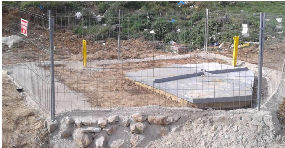
Adecuación arqueta registro de pluviales en el entorno del vaso de vertido, fase I
